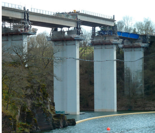
P20 - Reconstruction des tabliers d'un pont à Insenborn
