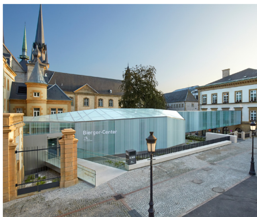
P22 - Passerelle Bierger Center
