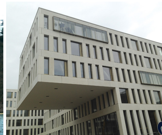
P14 - Immeuble administratif IAK
