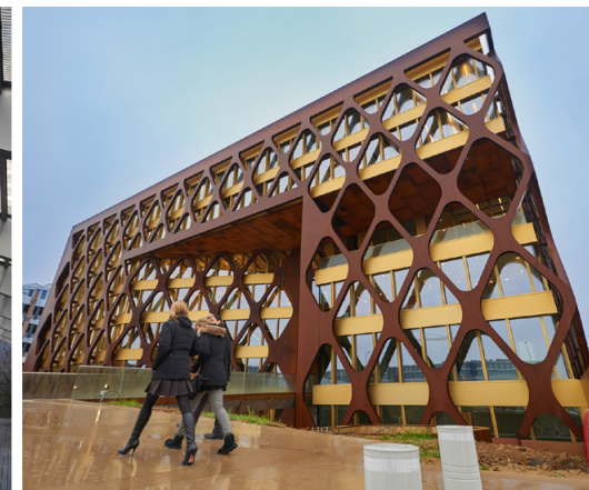
P02 - Immeuble de bureau KPMG
