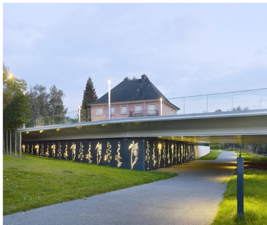
P18 - Reconstruction d'un pont routier à Hesperange
